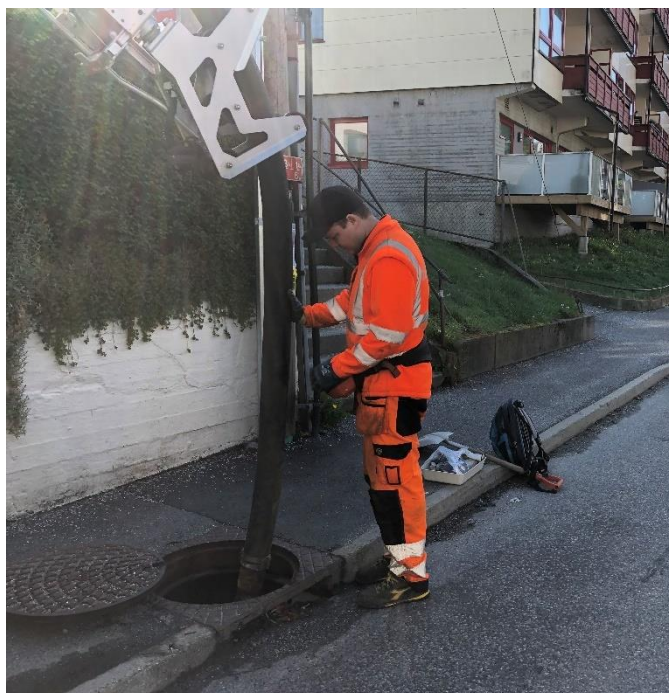
Figur 3.3. Til venstre: Kjøretøyet i ferd med å fjerne overvann fra et sandfang. Til høyre: Sedimentprøver tas med spade fra en sandfangskum. Foto: NORCE, Einar Bye-Ingebrigtsen.
